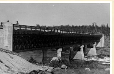
Pont en bois créosoté sur la Rivière-aux-Outardes, Côte-Nord. Des piliers en béton soutiennent ce pont à poutres droites composées.
