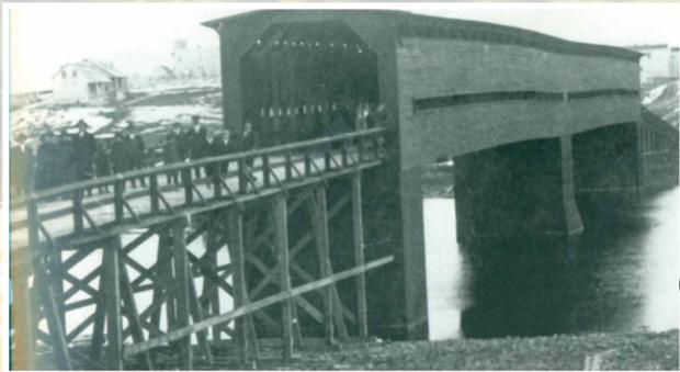
Pont couvert, construit en 1910, en Abitibi. Construction à trois piles et deux travées avec culées en ossature en bois.
