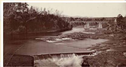
Pont à poutres droites en haut des chutes de la rivière Montmorency, vers 1860. Le pont est muni de trois travées dotées chacune d'une ferme de toit (*truss*) montée au moyen de deux pièces de charpente (appelés arbalétriers) qui s'étirent au-dessus du niveau de passage et qui soutiennent le tablier en son milieu au moyen d'une moïse.
